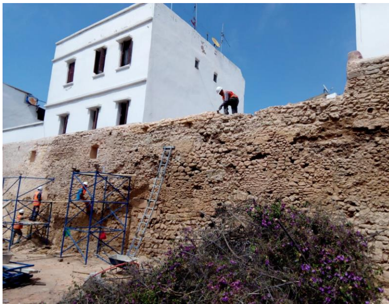
Travaux de confortement de la muraille
