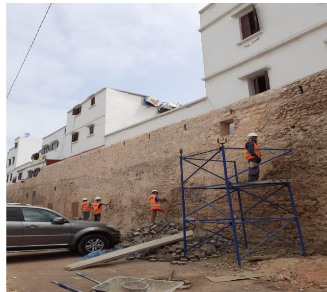
Travaux de confortement de la muraille
