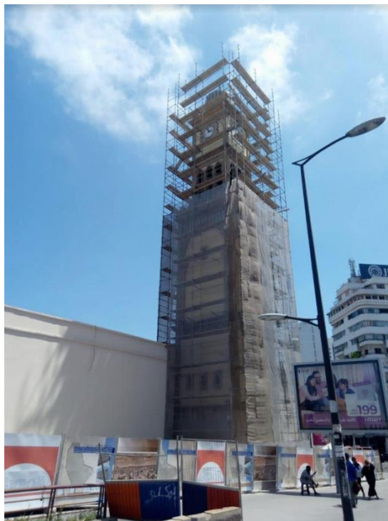
Travaux de confortement de l'horloge
