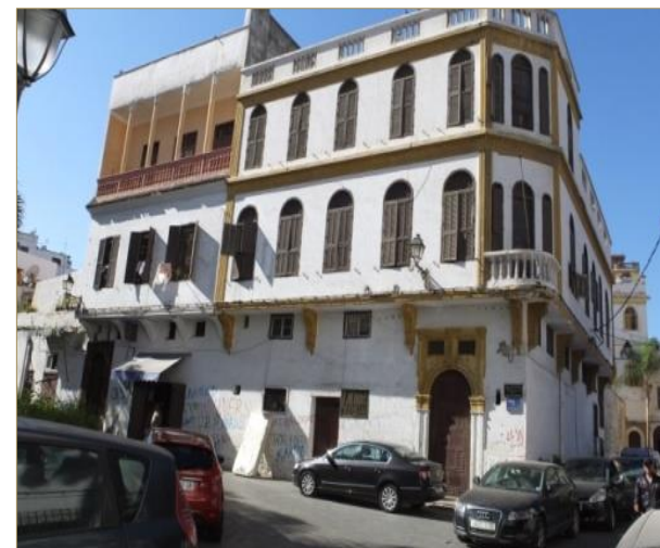
Exemple d'édifices à caractère architectural et patrimonial
