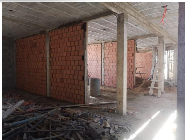
Etat des travaux
